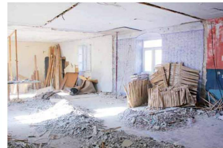
Il cantiere riguarda il secondo piano della parte barocca dell'edificio
